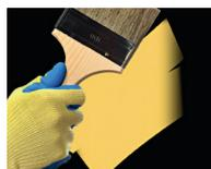
8. Applicare 1 mano di Silic One 77450 (topcoat) sull'area danneggiata coprendo un'area leggermente più grande dell'area con il tiecoat Silic One (completare la superficie sotto la linea di galleggiamento quando si ripittura).
